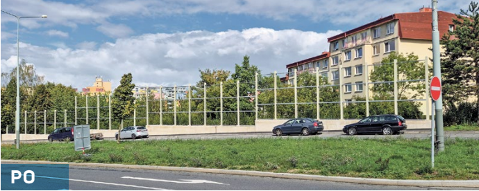
Protihlukové stěny podél Ocelkovy ulice od výstavby této části sídliště pouze chátraly. Už bylo na čase to razantně změnit.
