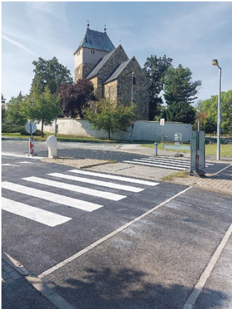
Oprava zvýšeného přechodu na Broumarské nebyla jednoduchá. Přinesla spoustu kritiky, stížností i osobních útoků. Dnes ale výborně slouží řidičům, chodcům i kostelu a jistě ještě dlouho bude.
